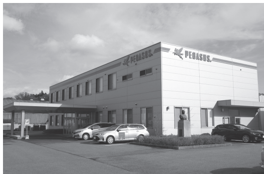
写真1 ペガサスミシン製造滋賀工場
