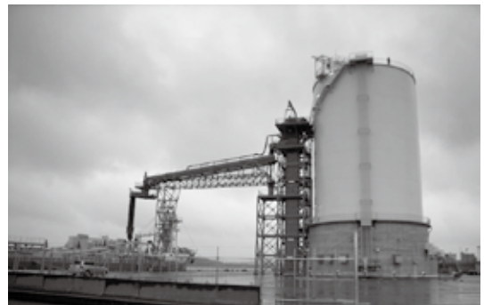
写真2 スペロセイキが製作した陸上設備(シップローダー/粉体を船舶に積み込む設備)
