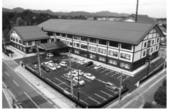
写真1 デザインコードに基づく和風デザインを採用した相馬市役所庁舎。免震構造で自家発電設備を有し、大災害時には災害対策の拠点となる
