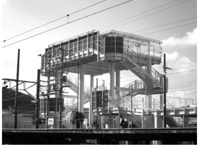
写真1 JR紀勢本線の周参見駅の上につくられた津波避難タワー（和歌山県） （撮影・日刊工業新聞社）
