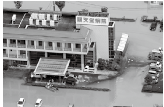
写真2 浸水した佐賀県大町町の順天堂病院
