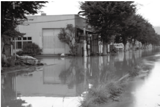
写真1 台風19号の被害の様子
