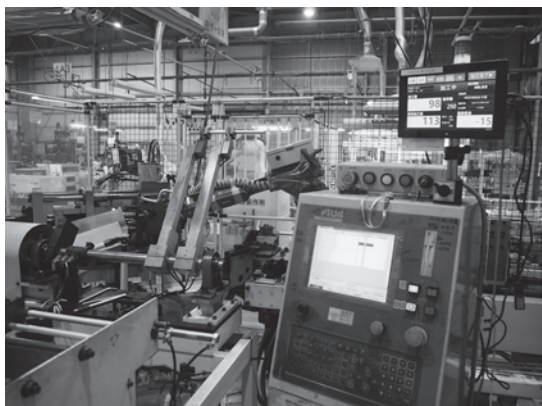
写真1 ロボットによる曲げ加工
