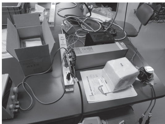
写真1 整理整頓ができていない作業台
