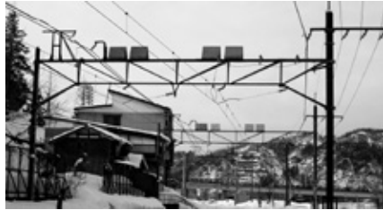
図表 1-2 V形トラスビーム落雪装置の例
