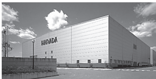
写真1 仙台工場の外観
