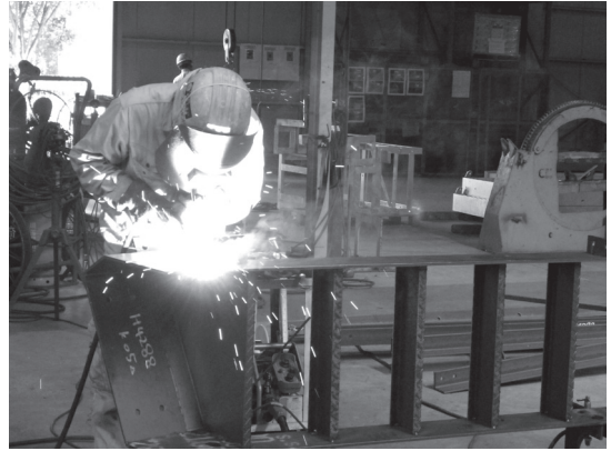
仮組みしたものを溶接して接合する
