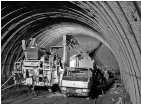
道路トンネル(山岳工法)の内部。あばら骨のような鋼製支保工やロックボルトの頭部が見える。
