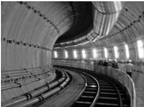
下水道トンネル(シールド工法)の内部。大断面かつ急曲線部。
