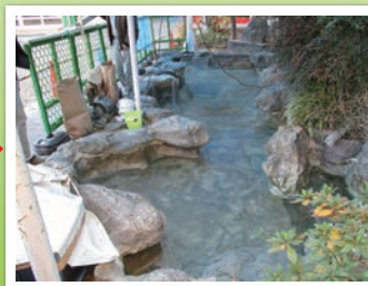
FRPライニング
