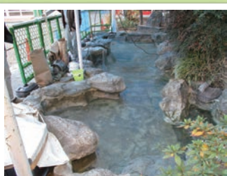
FRPライニング
